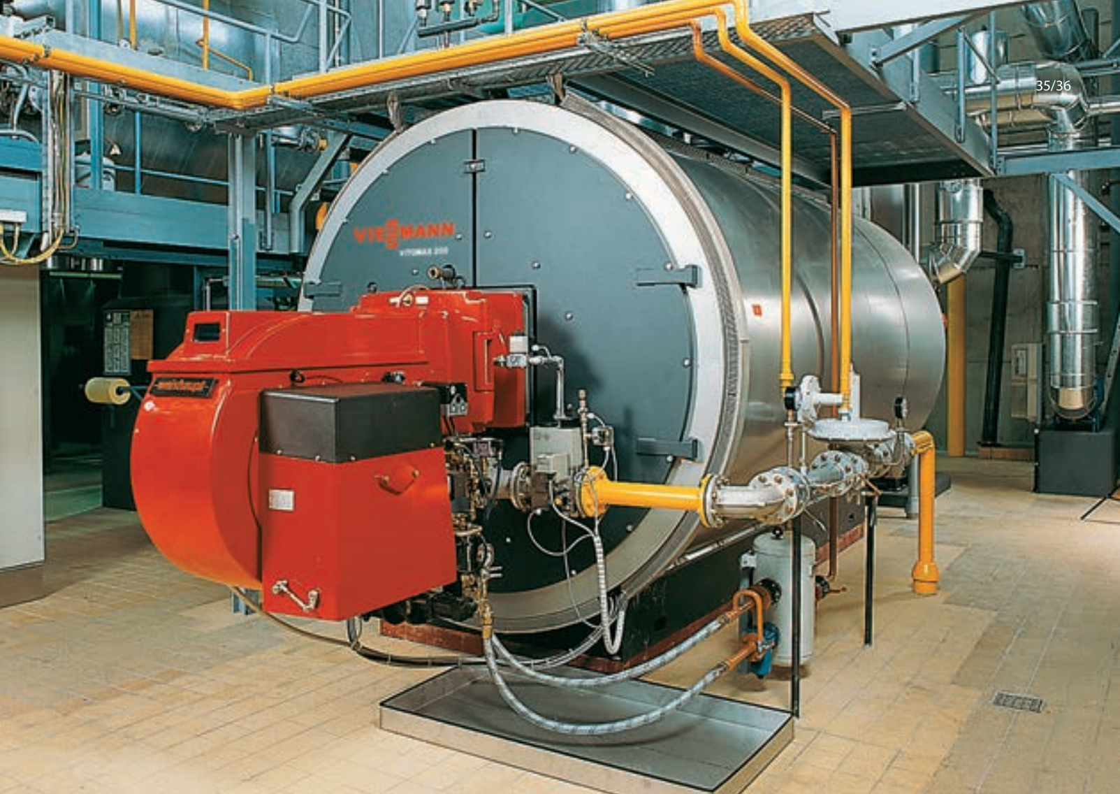
Vitomax 100-LW, тип M148
