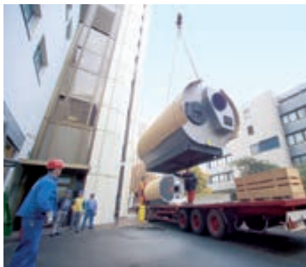
Транспортировка и разгрузка котла Vitomax
